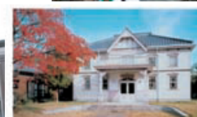
二水会館(旧水海道町役場)
